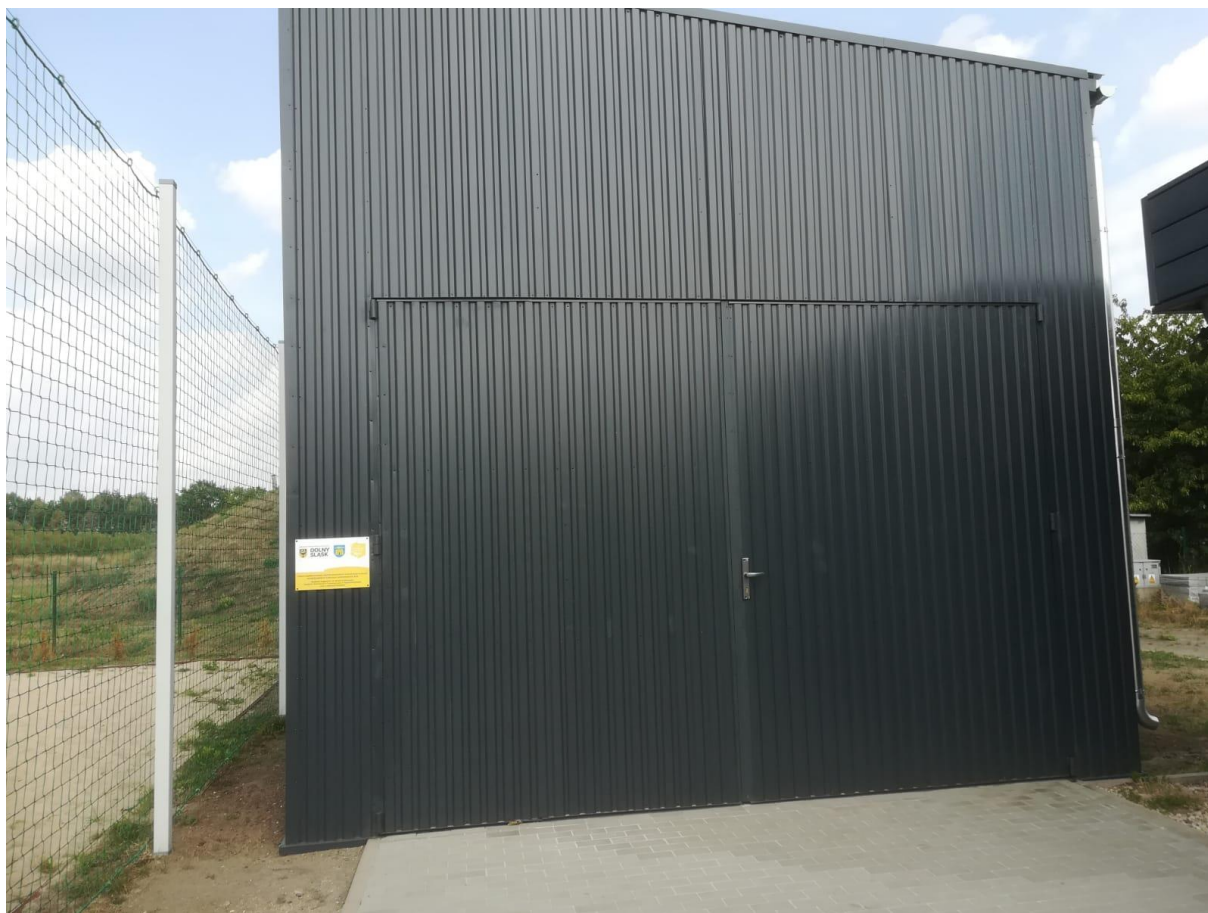
Fot. 5 Magazyn na sprzęt wodny CRT Radomierzyce
